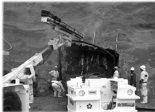
Source: Shotcrete, Dennis Van Heerden, Minova RSA, 2012
